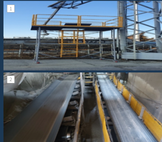
1. 한일현대시멘트 이동식 틀비계 안전난간 설치 2. 한일시멘트 크링커 이송 방호울 설치
